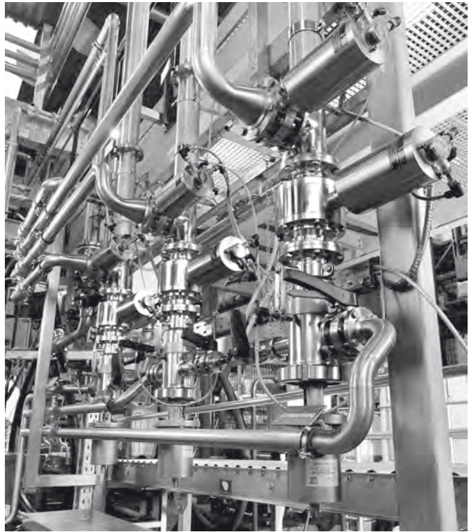
Guth Ventile Molchanlage in einer Produktion
